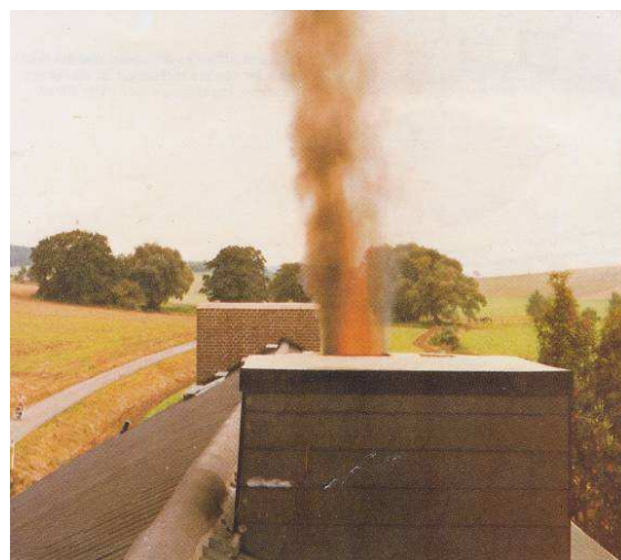
Bild 2 und Bild 3 : Offenes Flammenbild an der Kaminmündung
