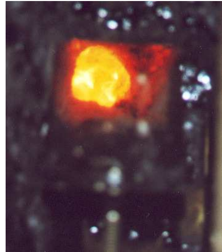
Bild 7: Kaminbrand aus dem Blickwinkel eines Kaminspiegels
