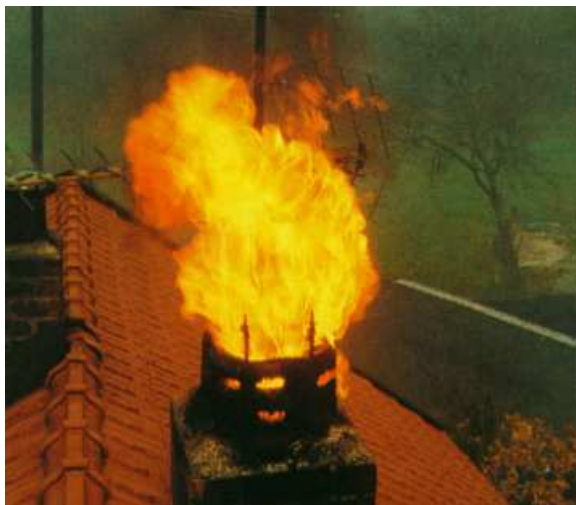
Bild 2 und Bild 3 : Offenes Flammenbild an der Kaminmündung
